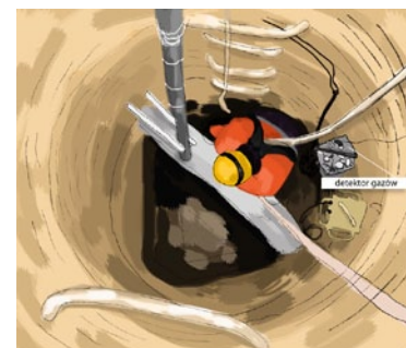
Rys. 7. Prace w wykopach i studzienkach kanalizacyjnych
