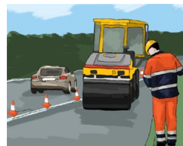
Rys. 1. Wygrodzenie pasa ruchu drogowego pachołkami drogowymi
