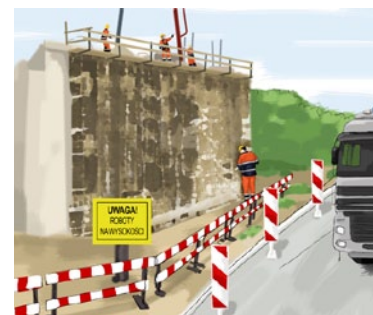
Rys. 1. Zabezpieczenie i oznakowanie terenu prac na wysokości
