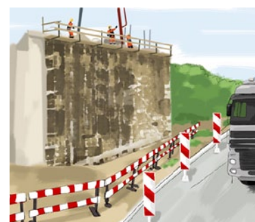
Rys. 5. Zabezpieczenie prac na wysokości balustradą ochronną
